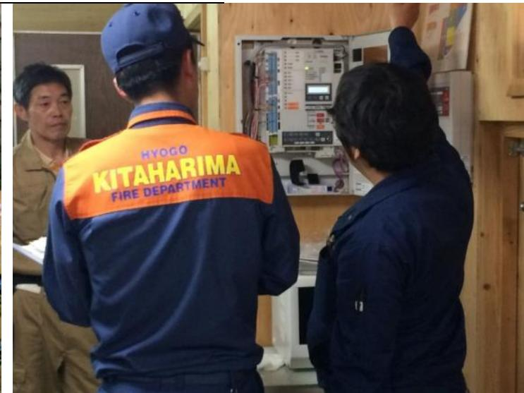
高所作業車を使用して、3 棟すべて天井に火災感知器を設置しました。火災を感知した際は事務所のコントロールパネルに通信が届き、消防署へ自動通報される仕組みになっています。写真は 5 月 24 日の完了検査の様子です。（左写真）感知器が正常に作動するか加熱して試験を行っています。（右）コントロールパネルの作動状況を確認しています。
